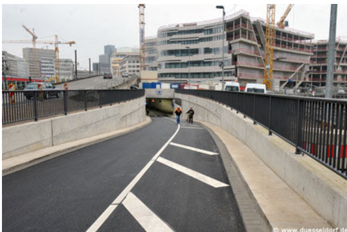
Freigabe des ersten Kö-Bogen-Tunnels am 7. Januar 2013.
