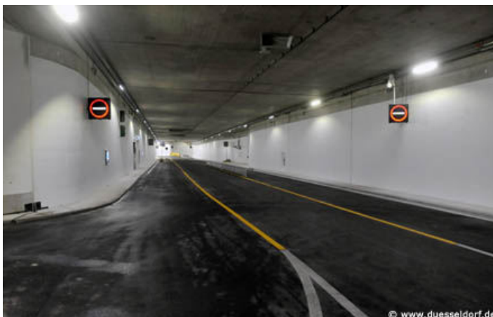
Freigabe des ersten Kö-Bogen-Tunnels am 7. Januar 2013.
